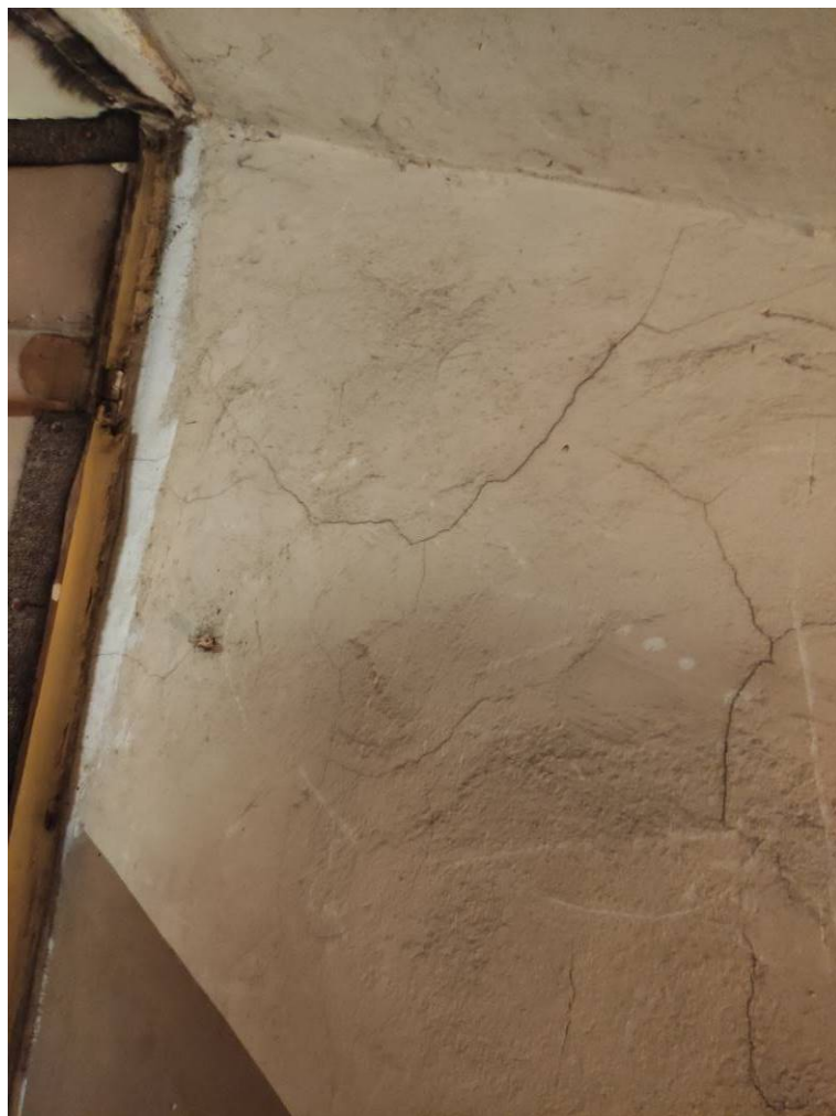
Zdjęcie nr 3.6. Widok zarysowań na tynku w rejonie ściany – zejście do piwnic
