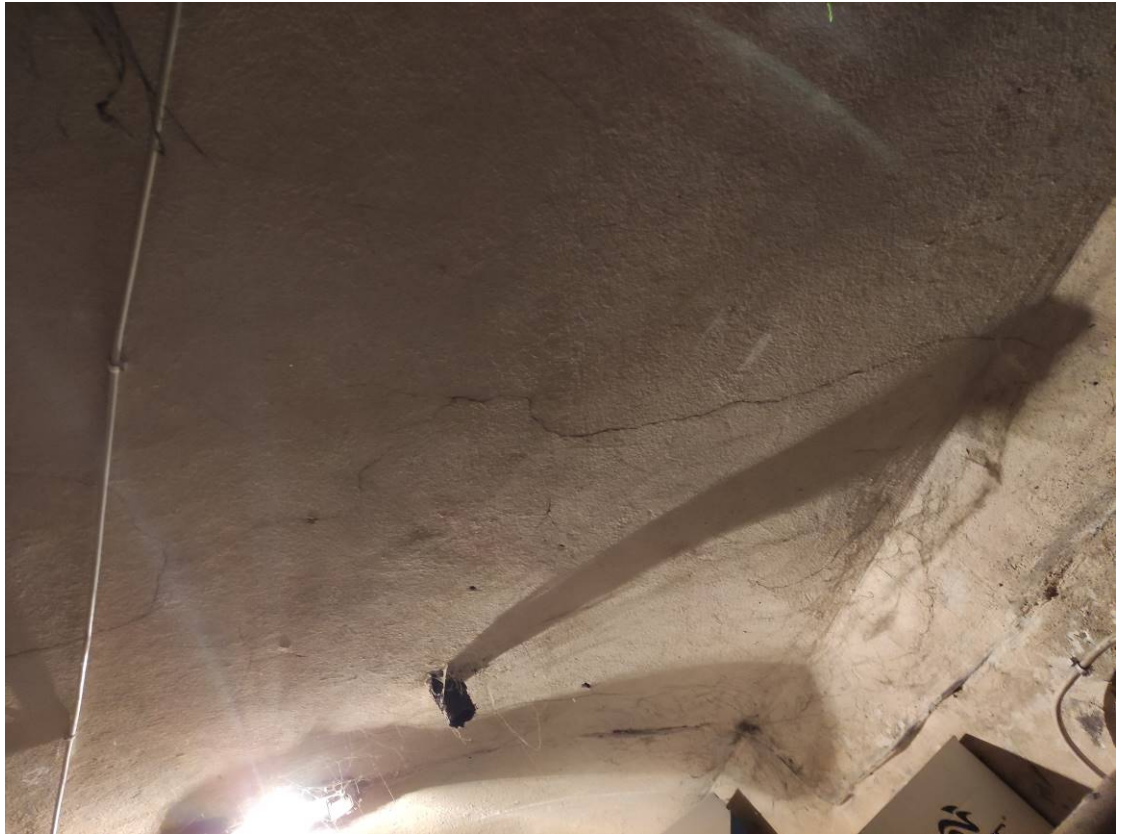
Zdjęcie nr 3.5. Widok zarysowań tynków na stropie kolebkowym w rejonie piwnic.
