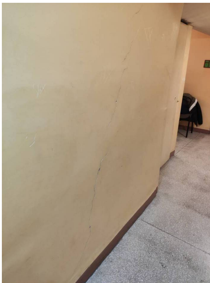
Zdjęcie nr 3.4. Widok zarysowania ukośnego na ścianie nośnej w korytarzy z propagacją na lastriko.
